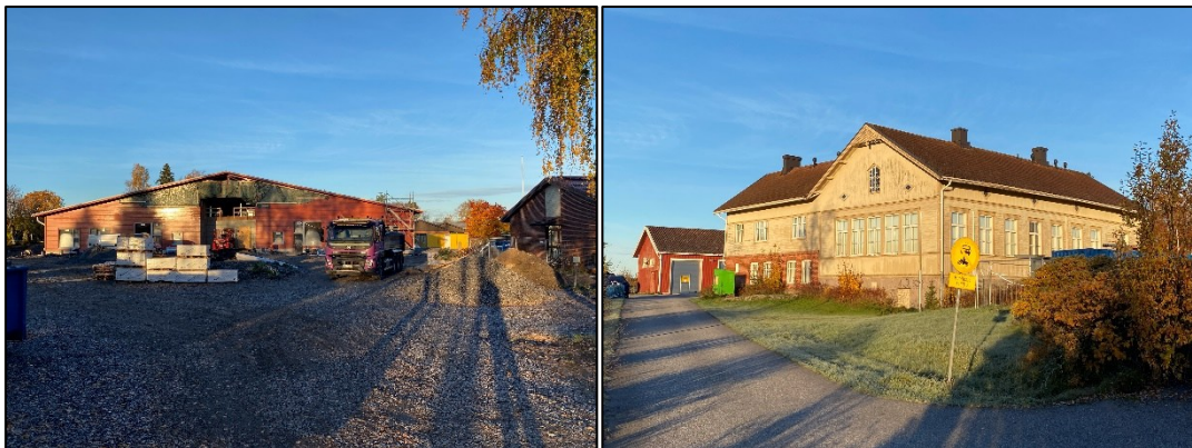
Rakenteilla oleva päiväkoti ja nuorisotalo, entinen kansakoulu.
